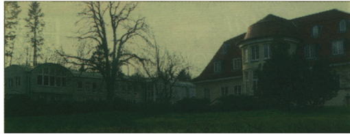
Vom Schlaf- und Pflegebereich der Kinder soll einmal ein Übergang zum Haupthaus geschaffen werden
